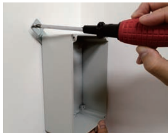
通过安装挂脚固定
