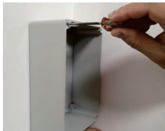
通过盒体的通孔用螺丝直接固定
